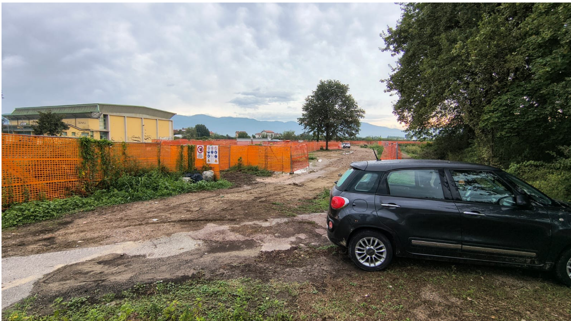
Viabilità di accesso al cantiere dell'erigendo centro polivalente
