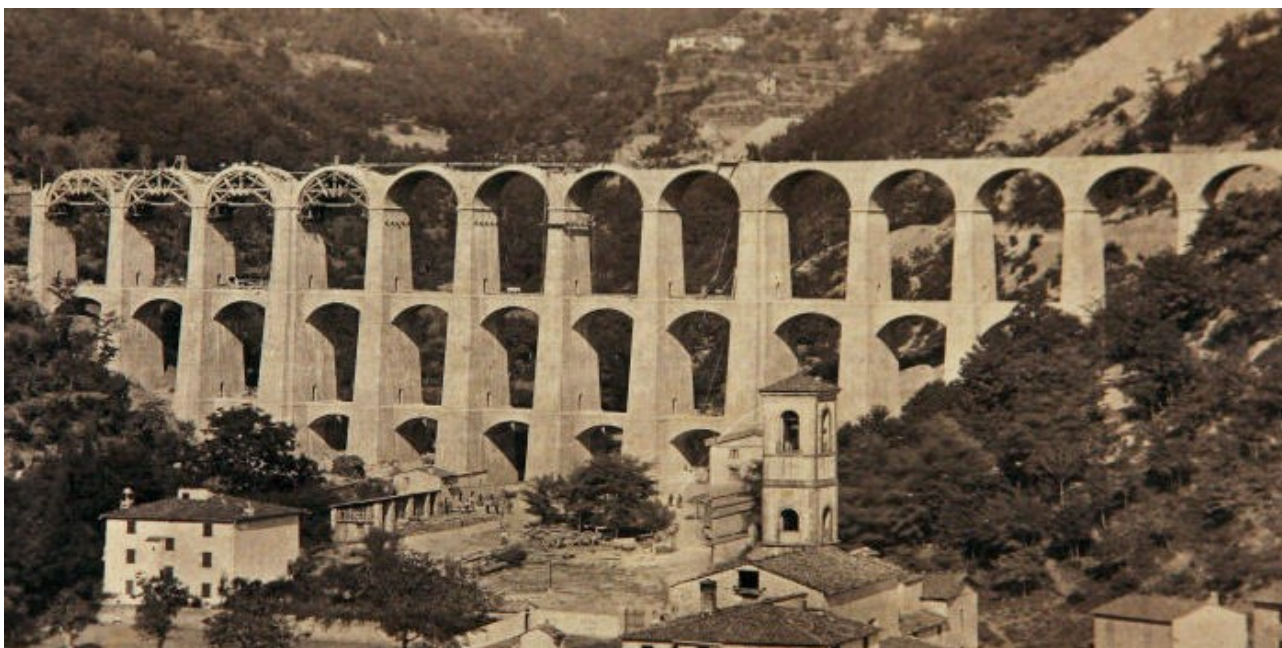
Il viadotto della ferrovia Porrettana a Piteccio
